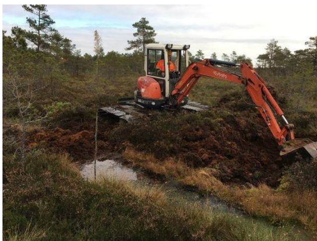
3.attēls. Dambju būvēšana Madiešēnu purvā, dabas liegumā „Augstroze” (foto: I.Silamiķele)
